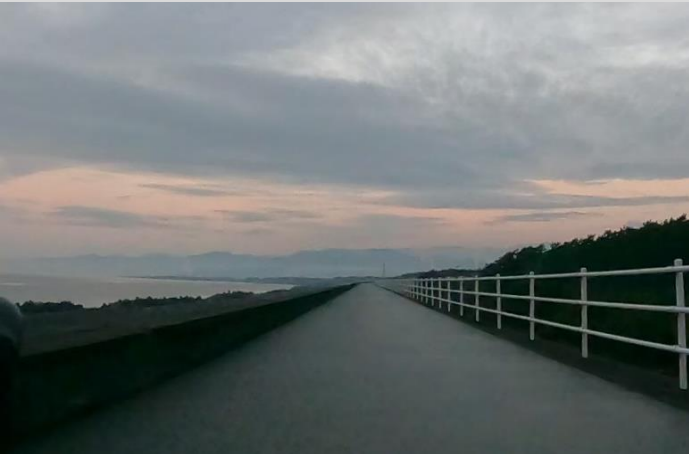
写真4 (駿河湾海岸堤防)
