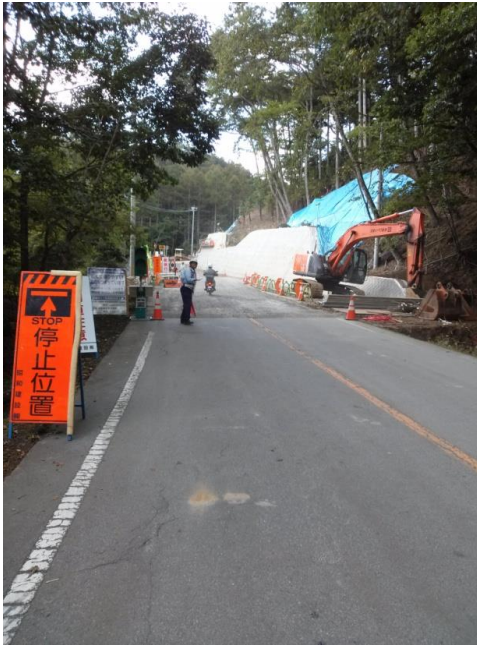
<峠手前3 キ の道路改良工事区間>
