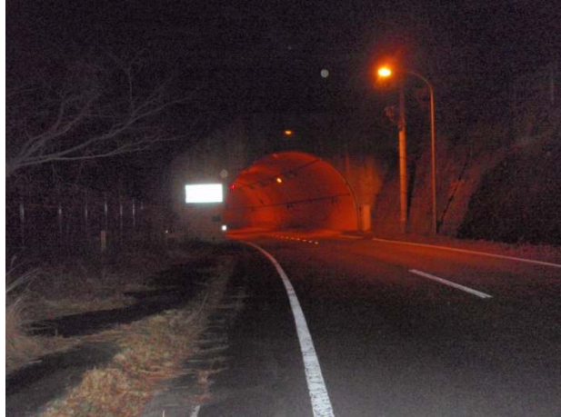
<井田トンネルー上り終了！>
